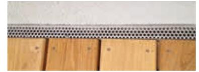
Draufsicht: Hinterlüftung mit dem Alugitter zu angrenzenden Bauteilen.
